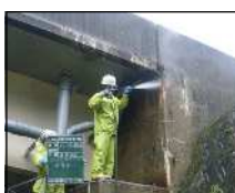
洗浄(道路構造物)
