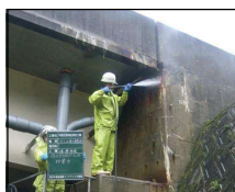
洗浄(道路構造物)
