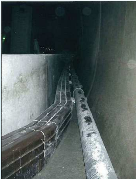
非常駐車帯部曲線管路
