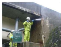
洗浄(道路構造物)
