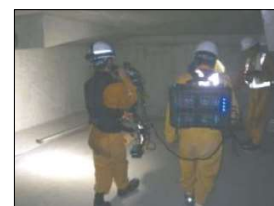
箱桁橋の内部などの狭隘箇所は 『小型ビデオカメラ』により対応
