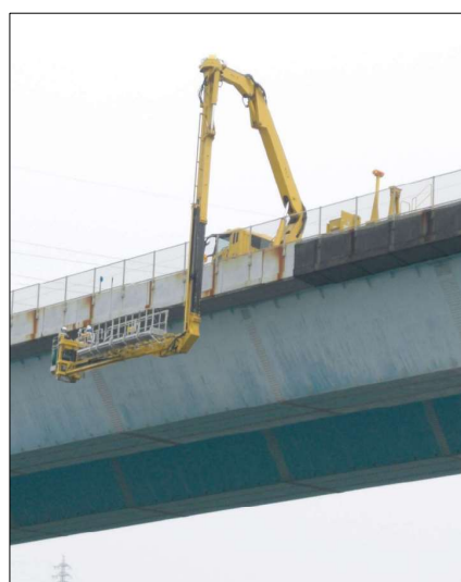
点検技術者による近接目視
