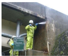
洗浄(道路構造物)
