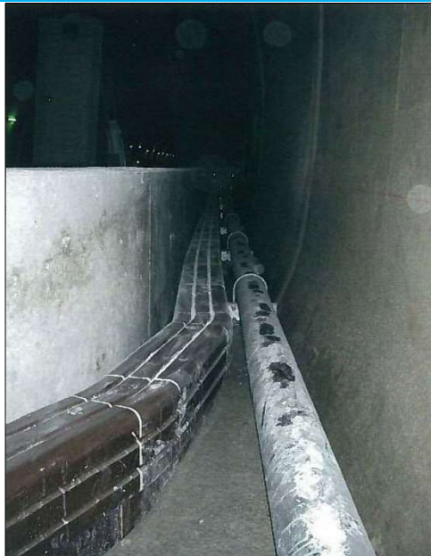
非常駐車帯部曲線管路
