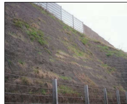
④ 取付完了
