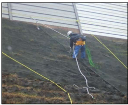
③ アンカーピン取付状況
