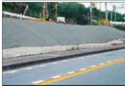
鉄道法面防草
